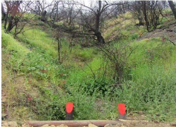
En las fotografías se indican empalizadas a favor de la ladera quemada, para evitar la formación de cárcavas y escurrimiento de material fino.
